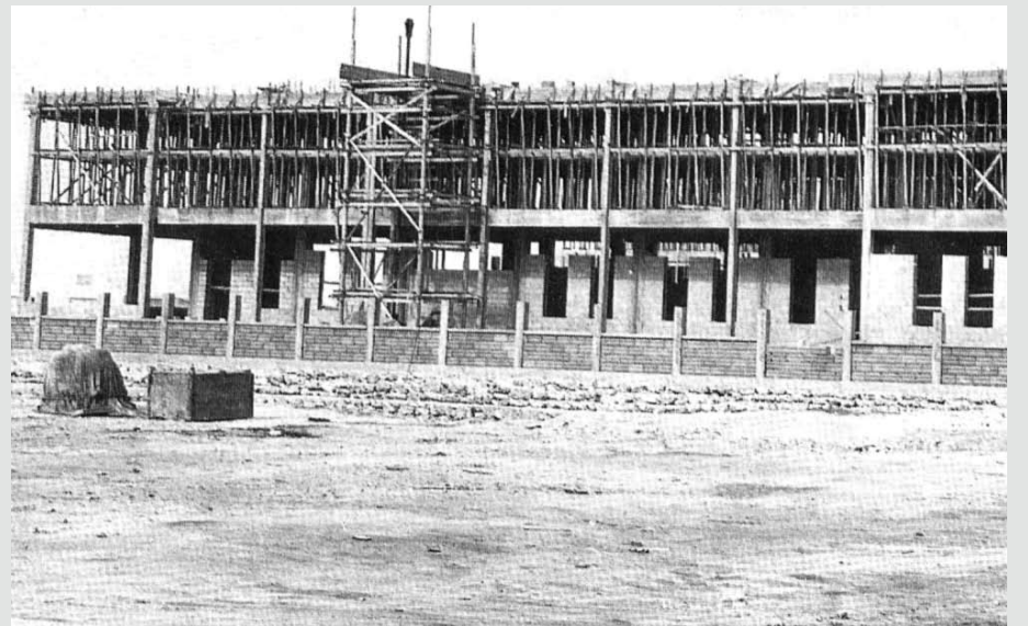
مبنى بلدية المنامة الجديد قيد الإنشاء في عام 1960م
